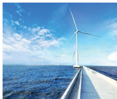
ĐIỆN GIÓ SÓC TRĂNG
