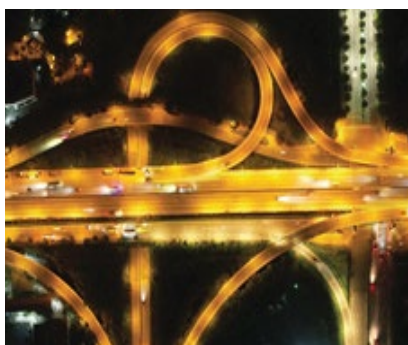
HỆ THỐNG ĐIỆN ĐƯỜNG VÀNH ĐAI 3
